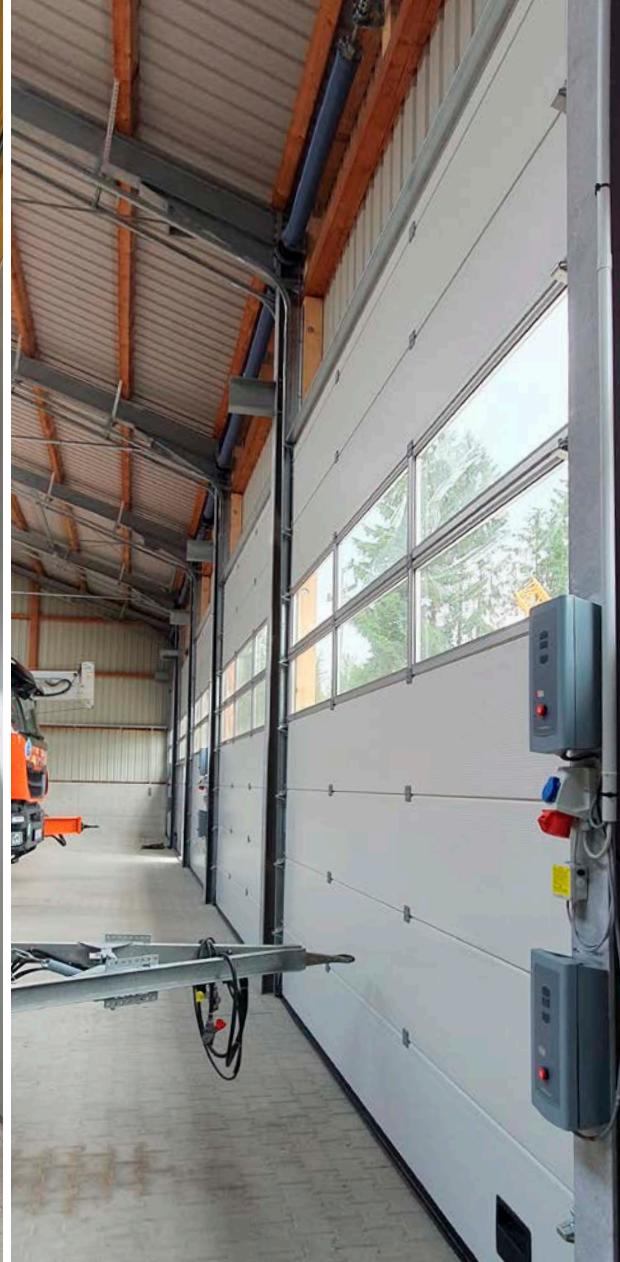
Porta OSP con sollevamento e montaggio del seguipersona a tetto
